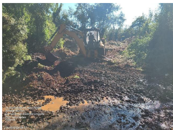
FOTO 3 – MÁQUINA REALIZANDO MELHORIAS NO ACESSO AO SETOR 4.
