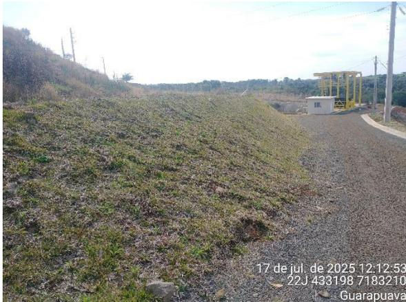
FOTO 27 – ÁREA EM RECUPERAÇÃO PRÓXIMA DO ANTIGO BARRACÃO, COM HIDROSSEMEADURA EM DESENVOLVIMENTO.
