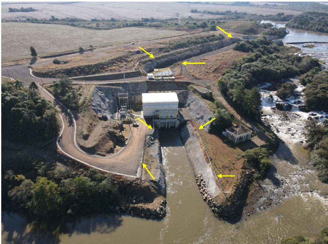
FOTO 38 – VISTA GERAL DO CERCAMENTO DA CASA DE FORÇA , CANAL DE FUGA E, AO FUNDO CANAL DE ADUÇÃO (JULHO/2025)
