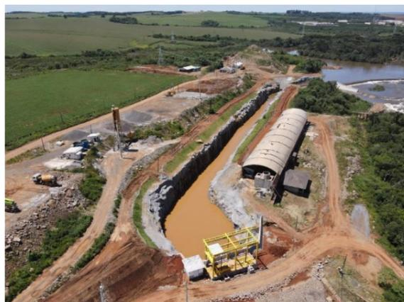
FOTO 57 – CANAL DE ADUÇÃO E TOMADA D'ÁGUA (DEZ/23) (BARRACÃO AINDA *IN LOCO*).
