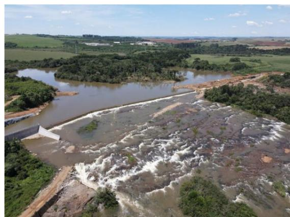
FOTO 61 – BARRAGEM APÓS A REMOÇÃO DA ENSECADEIRA FASE 1 - MARGEM DIREITA (DEZ/23).
