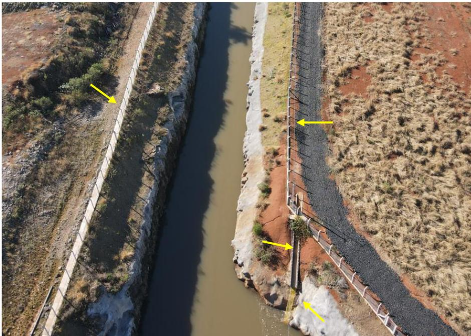
FOTO 40 – VISTA GERAL DO CERCAMENTO DO CANAL DE ADUÇÃO E DETALHE PARA DISPOSITIVO DE SAÍDA PARA A FAUNA (JULHO/2025)
