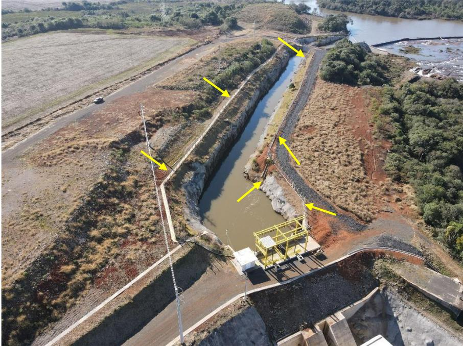
FOTO 39 – VISTA GERAL DO CERCAMENTO DO CANAL DE ADUÇÃO PARA A TOMADA DA ÁGUA (JULHO/2025)
