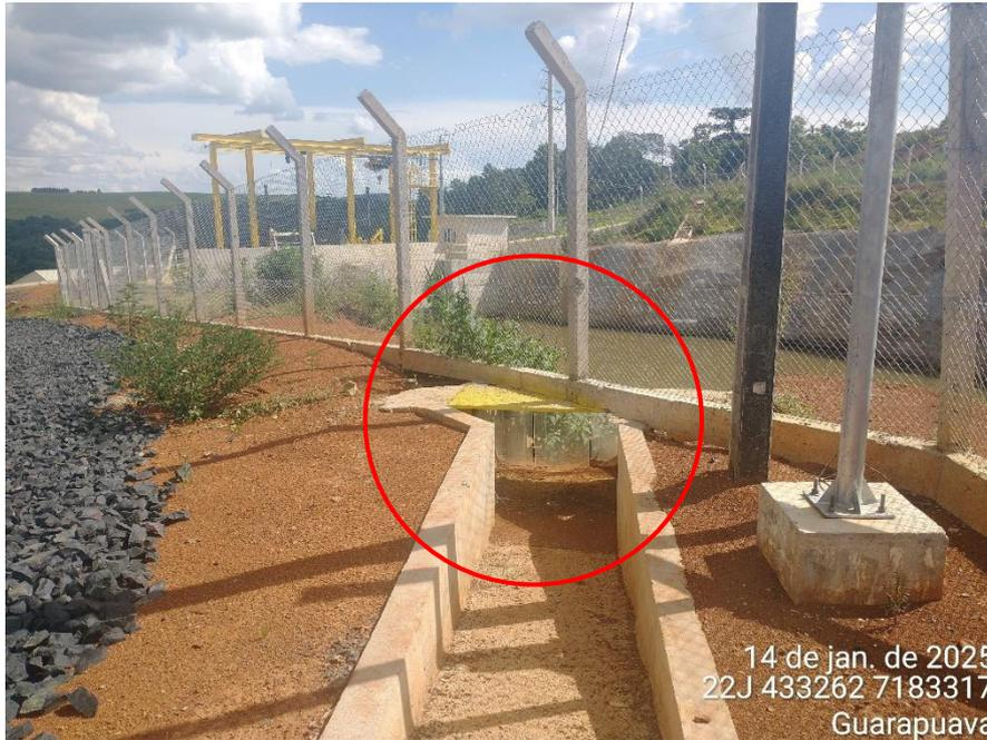
FOTO 36 – VISTA EXTERNA DE DISPOSITIVO DE SAÍDA PARA A FAUNA
