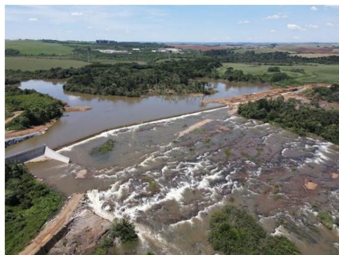
FOTO 54 – BARRAGEM APÓS A REMOÇÃO DA ENSECADEIRA FASE 1 - MARGEM DIREITA (DEZ/23).
