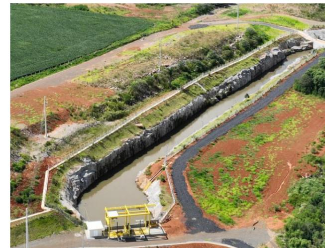
FOTO 53 – CANAL DE ADUÇÃO E TOMADA D'ÁGUA – DETALHE PARA ÁREA DO BARRACÃO EM RECUPERAÇÃO (JAN/25)
