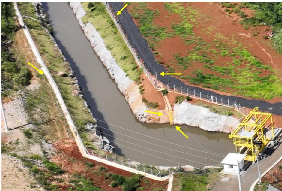
FOTO 35 – VISTA GERAL DO CERCAMENTO DO CANAL DE ADUÇÃO E DETALHE PARA DISPOSITIVO DE SAÍDA PARA A FAUNA (JANEIRO/2025)
